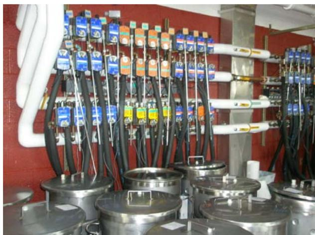
写真2 コーネル大学の試験醸造設備 (2) ポット仕込みの温度制御設備
